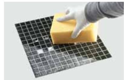
6 El exceso de sellador de juntas puede retirarse con una esponja húmeda durante el secado.
