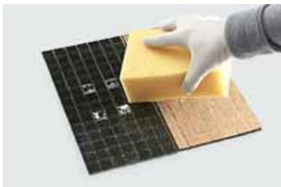
4 Antes del secado, retire cualquier exceso de pegamento con una esponja húmeda; siga las instrucciones del fabricante sobre el secado.
